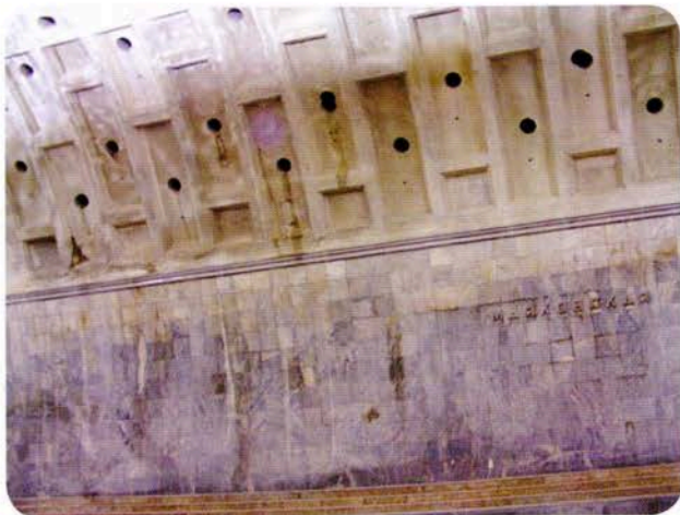
Рис. 4. Отверстия для инъектирования
