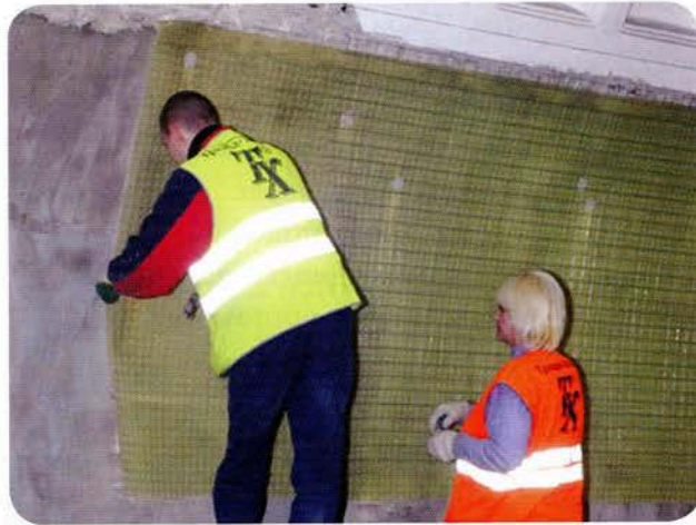
Рис. 5. Устройство системы дренажа
