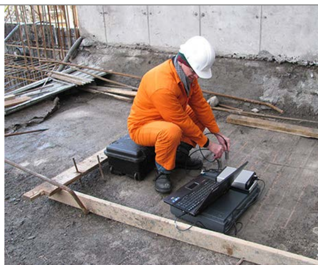
Рис. 10 Работа прибором PUNDIT на стройплощадке
